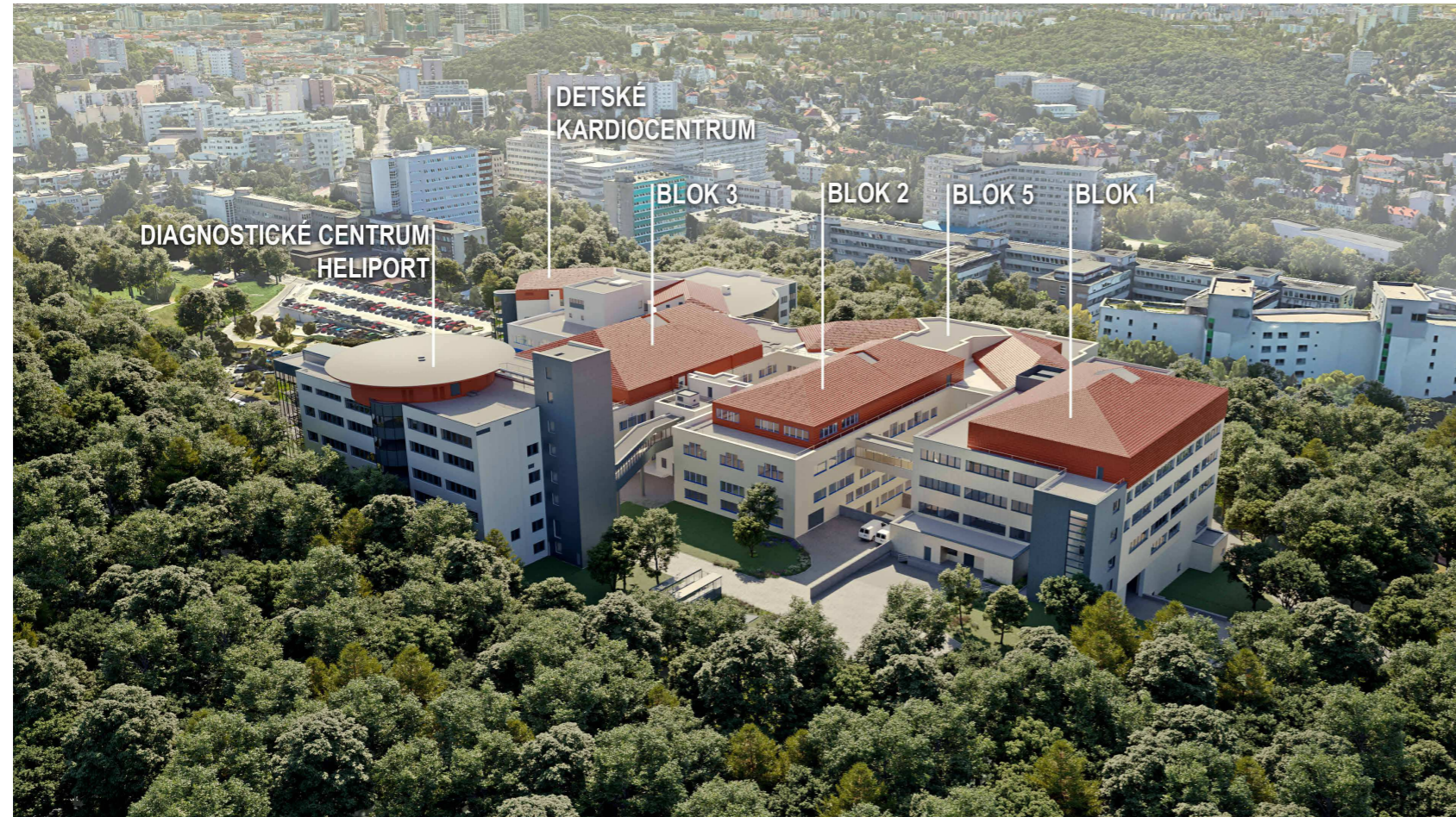
CELKOVÝ POHLAD ZO SEVEROZÁPADNEJ STRANY - OZNAČENIE JEDNOTLIVÝCH BLOKOV
