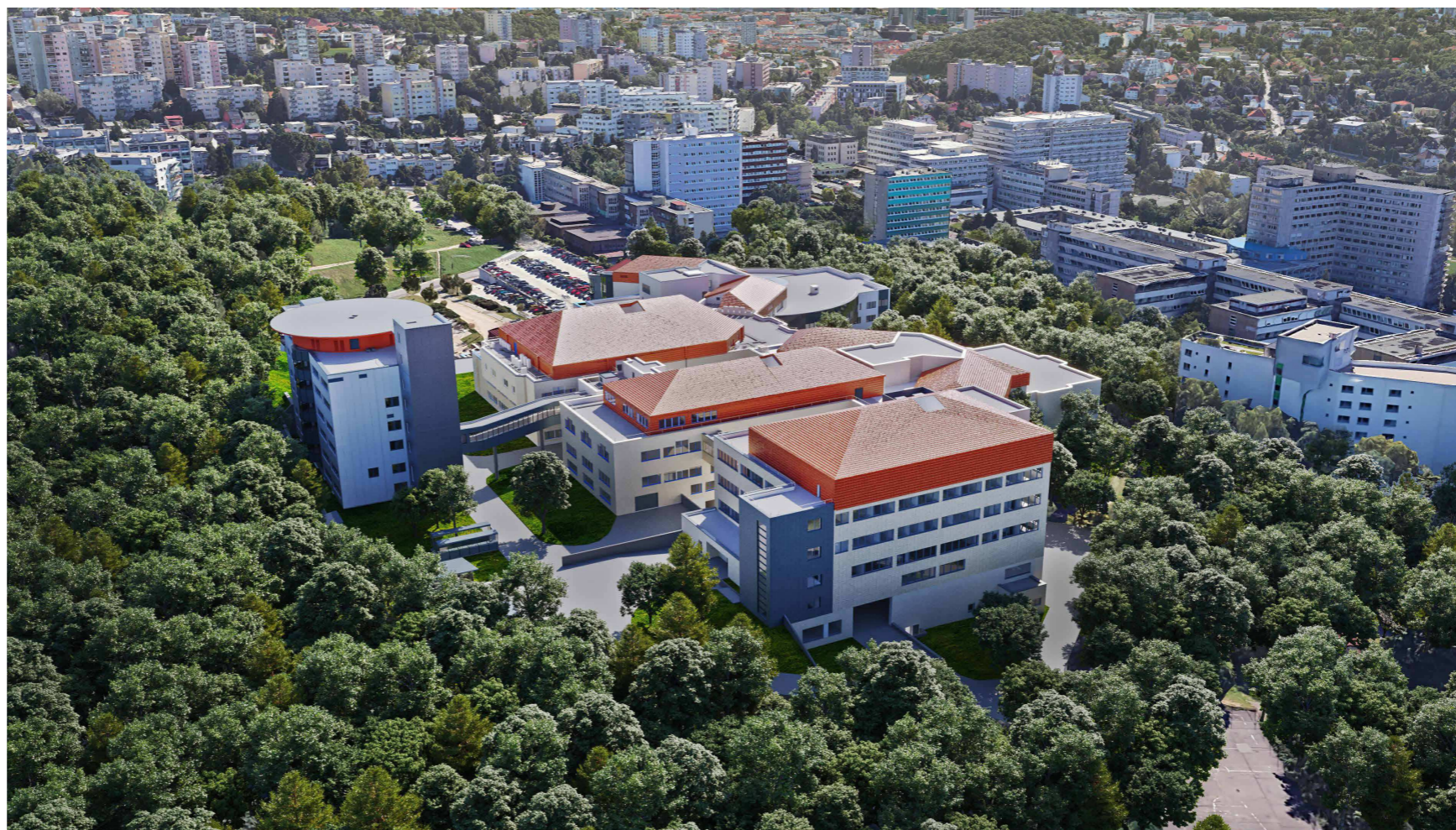
CELKOVÝ POHLAD ZO SEVEROZÁPADNEJ STRANY
