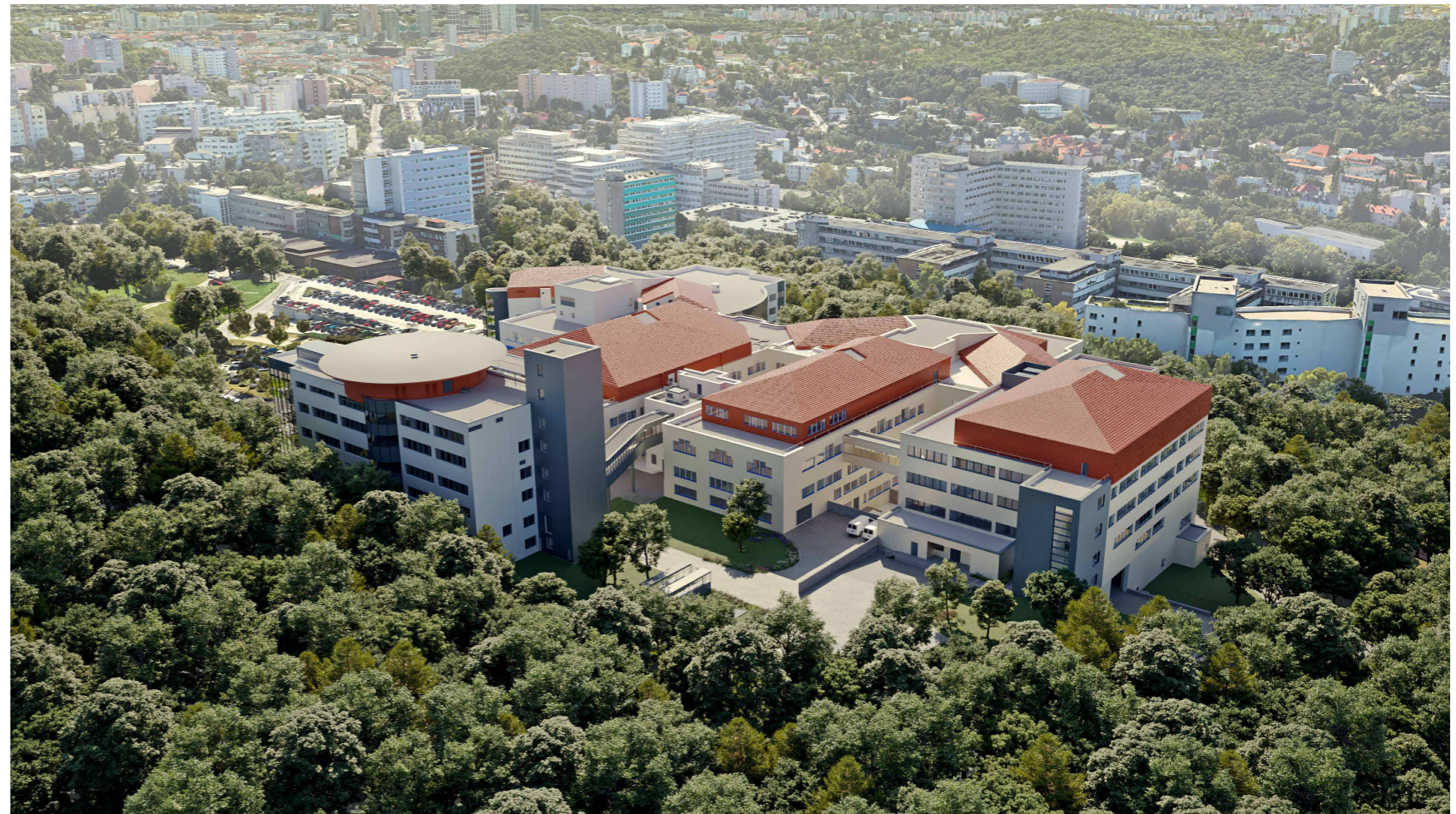
CELKOVÝ POHLAD ZO SEVEROZÁPADNEJ STRANY
